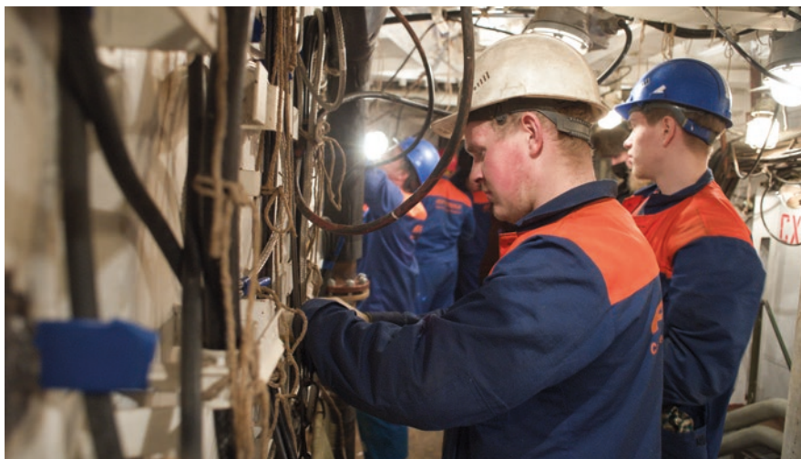
Выполнение электромонтажных работ на заказе
